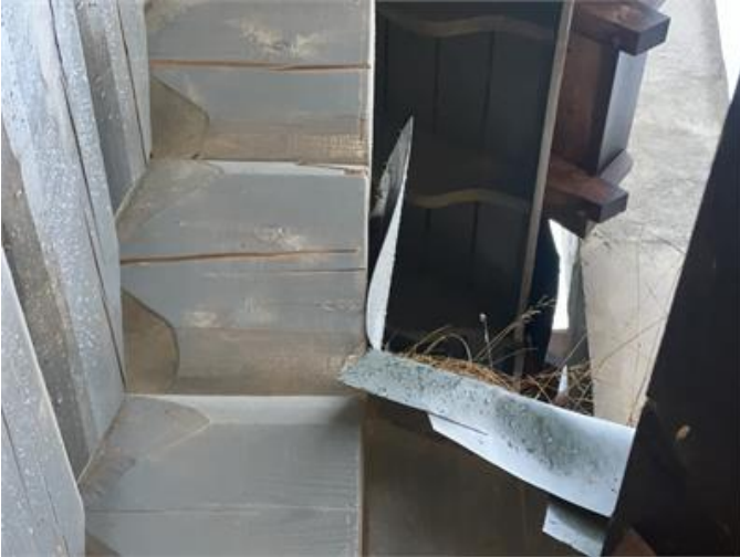
Takduk uppvik mot fasad.
