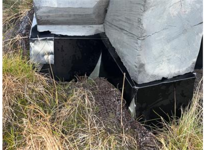
Täckplåt på tak mot fasad.
