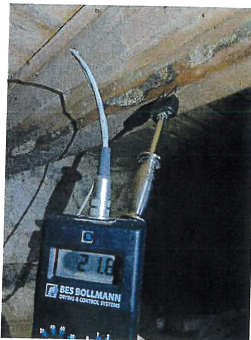
Grund Fuktkvotsmätning bjälklag
