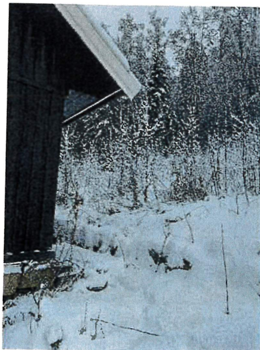
Utvändigt Stark sluttning förekommer mot bostad
